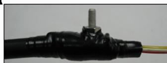
6.5 Установить верхнюю часть соединителя и закрепить гайкой. Наложить на соединитель и на прилегающие к нему участки ОК бандаж из двух-трех слоев ленты ПВХ на длине около 10 мм.
