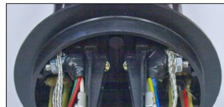
9 Закрепить ЦСЭ введенного в муфту ОК в узле крепления на кронштейне крепления ЦСЭ.
