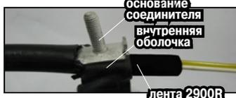
6.3 Вставить нижнюю часть соединителя между внутренней оболочкой с наложенной на нее лентой 2900R и наружной оболочкой, под стальную гофрированную ленту.
