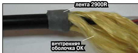
7.2 Уложить пучки арамидных нитей вдоль ОК в сторону разделанного конца, равномерно распределив их по окружности. Наложить на наружную оболочку ленту 2900R шириной 20 мм в один слой, размещая ленту симметрично относительно среза наружной оболочки.
