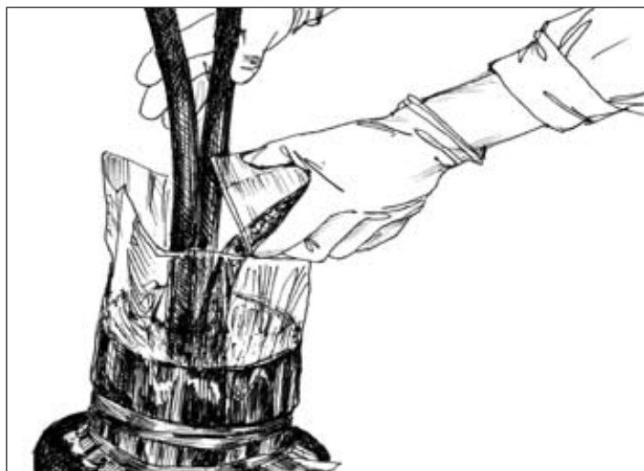
Рис. 3.5. Заливка герметика ВИЛАД-31 в горловину муфты МПЗ
