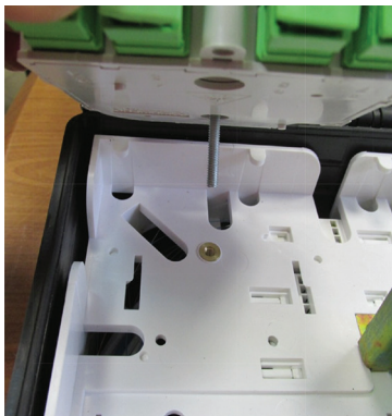
Рисунок В1 – Установка модулей СМЗ на кассету
